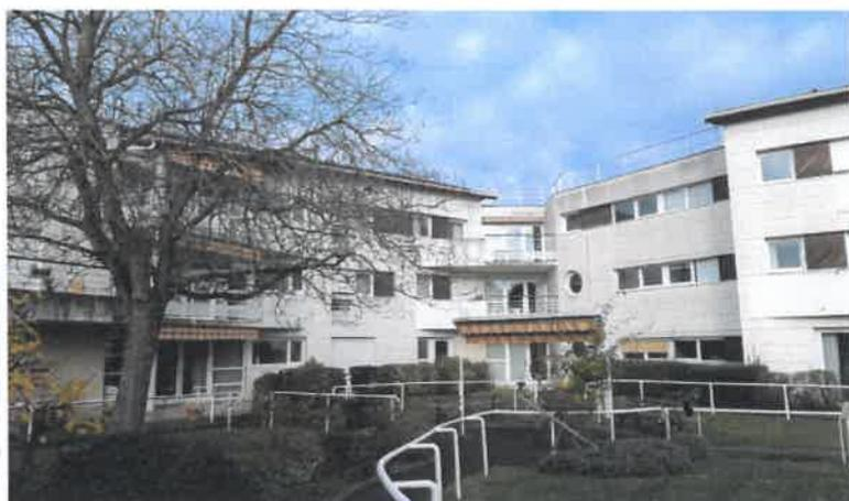
La maison de retraite est édifiée entre 1994/96. Il s'agit d'une construction R+2 étages avec une toiture-terrasse, sur 2 niveaux de sous-sol. Elle est desservie par ascenseurs.
