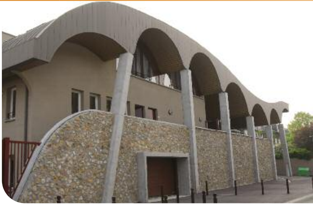
Cette structure moderne a ouvert ses portes aux petits Ermontois et Eaubonnais le 27 avril dernier.
