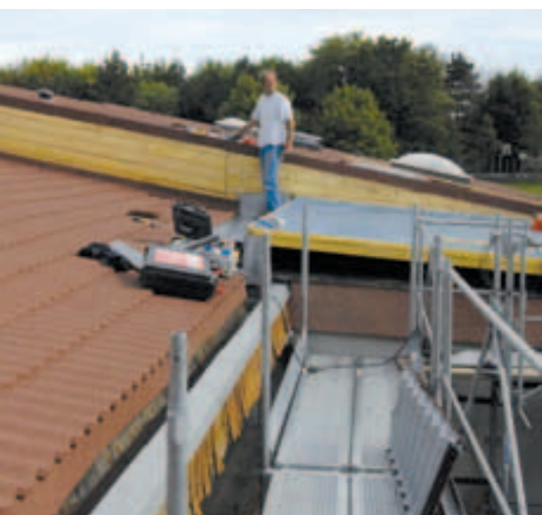
Toit de l'Accueil de loisirs Paul-Langevin.
