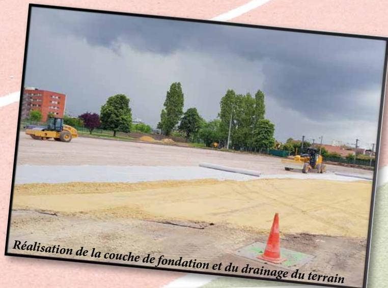
*Réalisation de la couche de fondation et du drainage du terrain*
